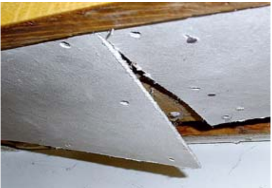
Asbesthaltige Leichtbauplatten
