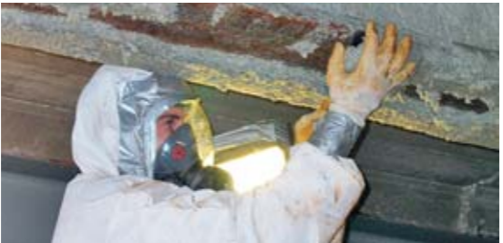
Asbestsanierung
